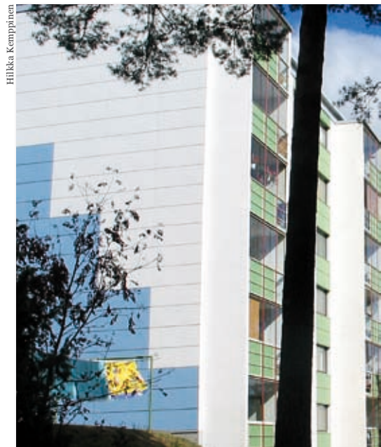
Julkisivukorjaukset piristivät koko Martinlaakson ilmeen.
